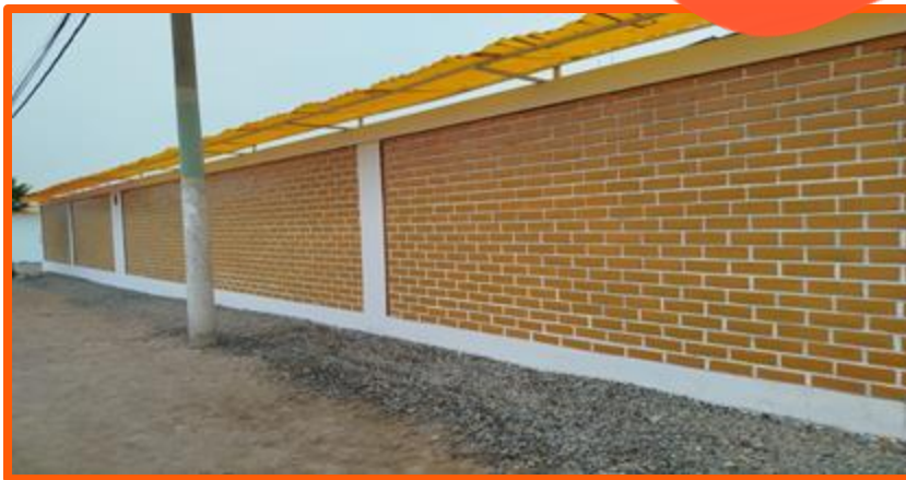
Pintado de la fachada de la escuela.
